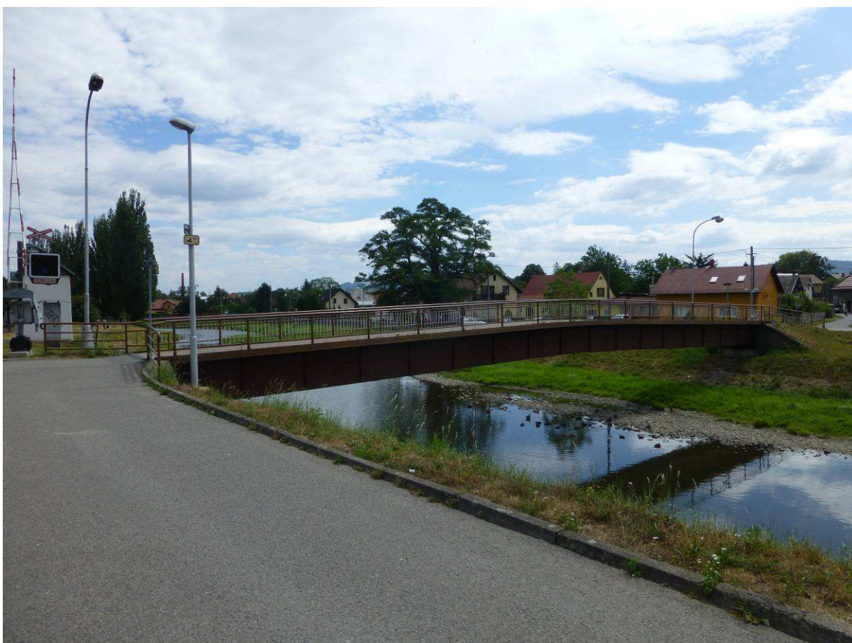
fotografie stávající lávky
