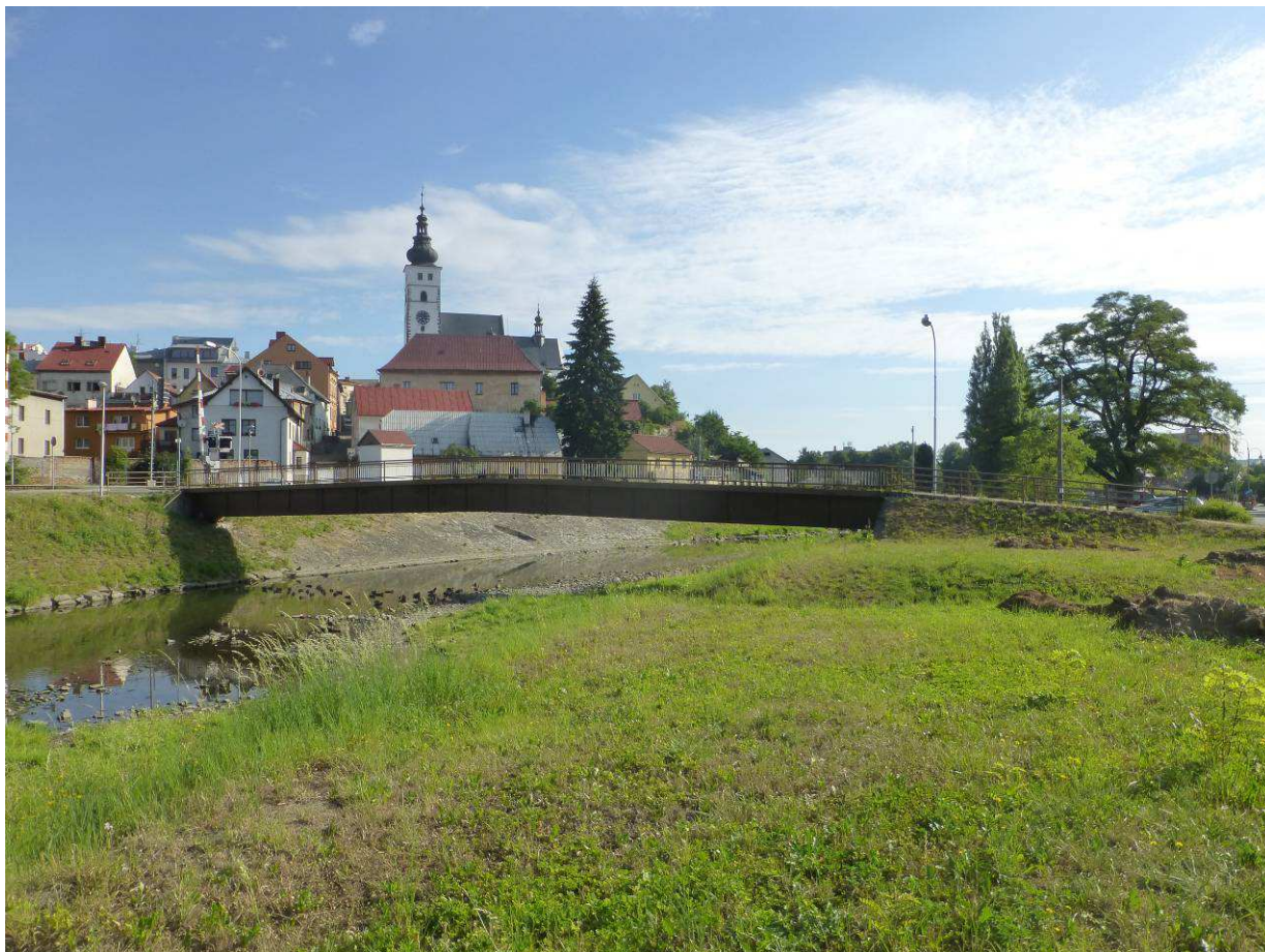
fotografie stávající lávky
