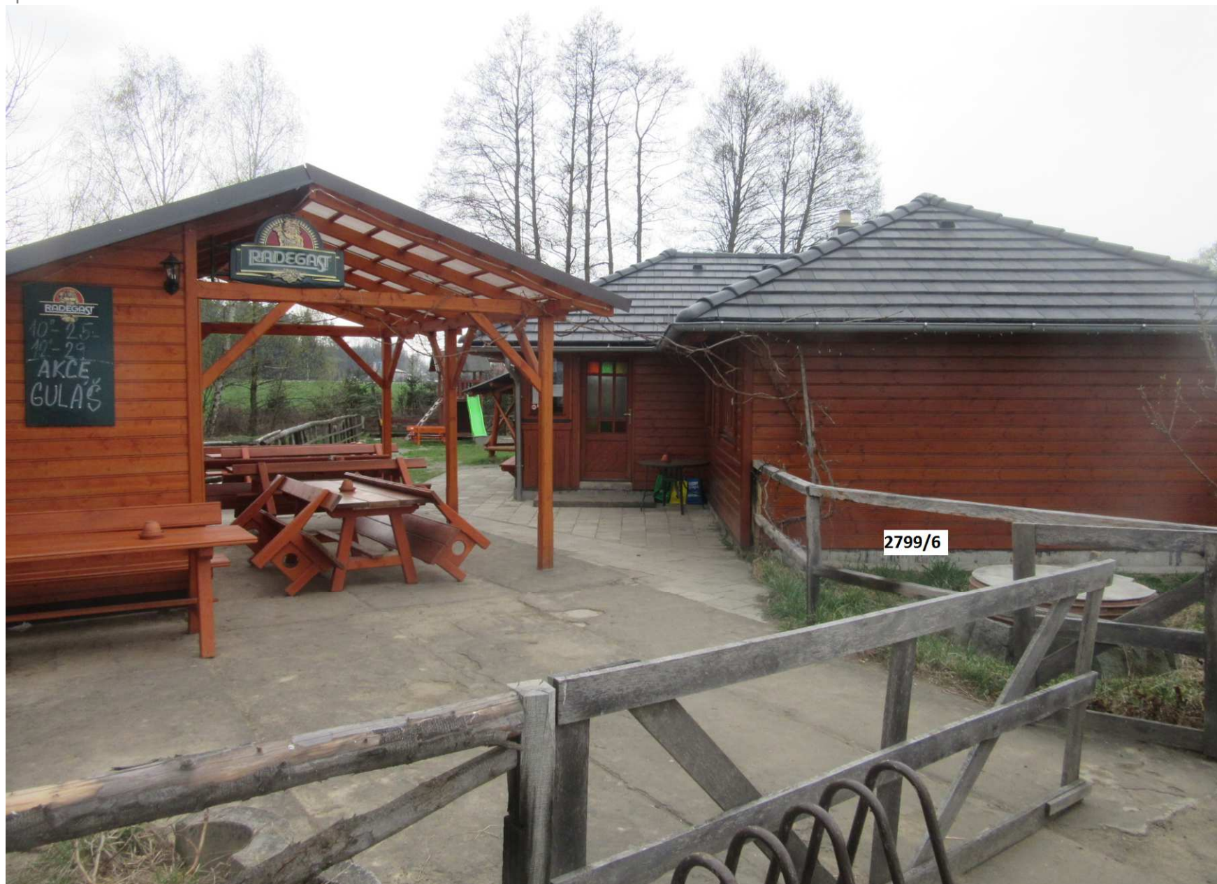
pohled od jihu
