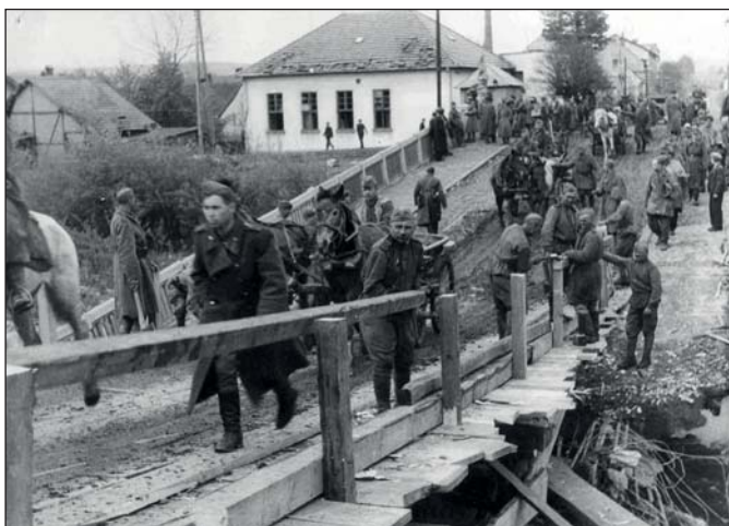
6. 5. 1945, vojáci Rudé armády přecházejí přes zničený klokočovský most
