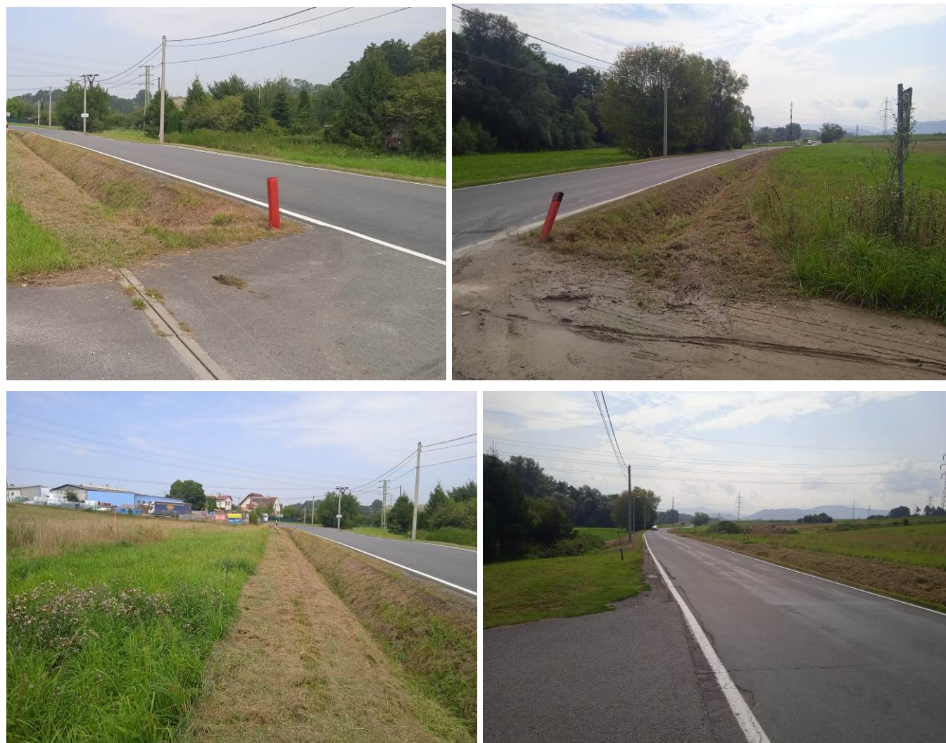
Obr.: Pohled z místa zapojení účelové komunikace do silnice III/4863
