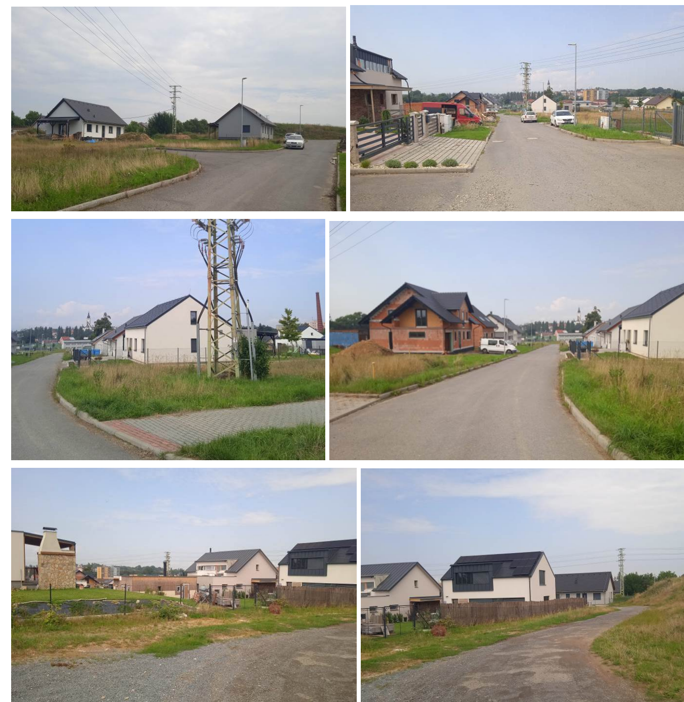
Obr.: Nová zástavba rodinnými domy podél ulice Hájovské a v jejím koncovém úseku
