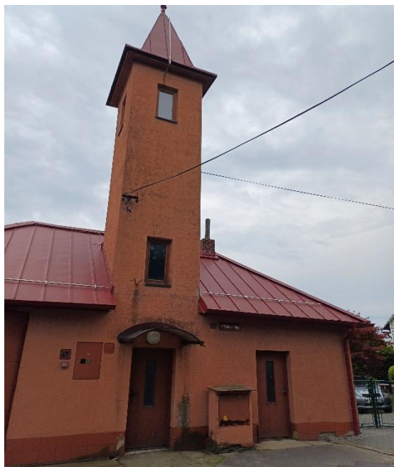
Obrázek 2.25 Požární stanice Prchalov
