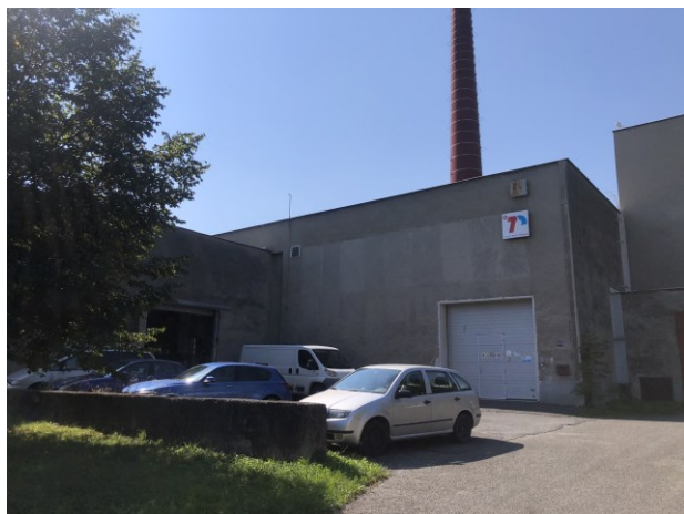
Parkoviště na ul. Lomená, u kotelny – potenciál pro uplatnění propustných povrchů nebo spádování do okolní zeleně.
