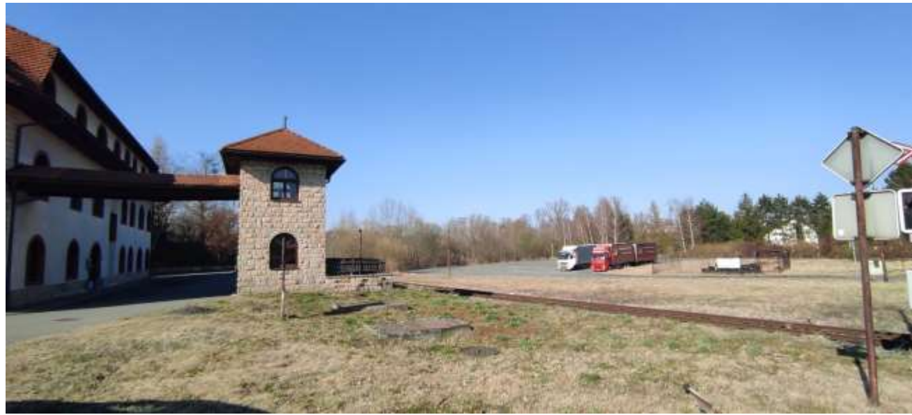
Fotodokumentace stávajícího stavu místa:
