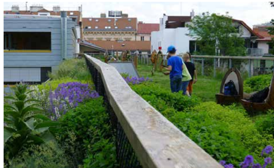
Zelené střechy jsou také efektivním opatřením, které funguje jak při zadržování dešťových vod, tak také brání přehřívání města v letních měsících (Brno - otevrenazahrada.cz).
