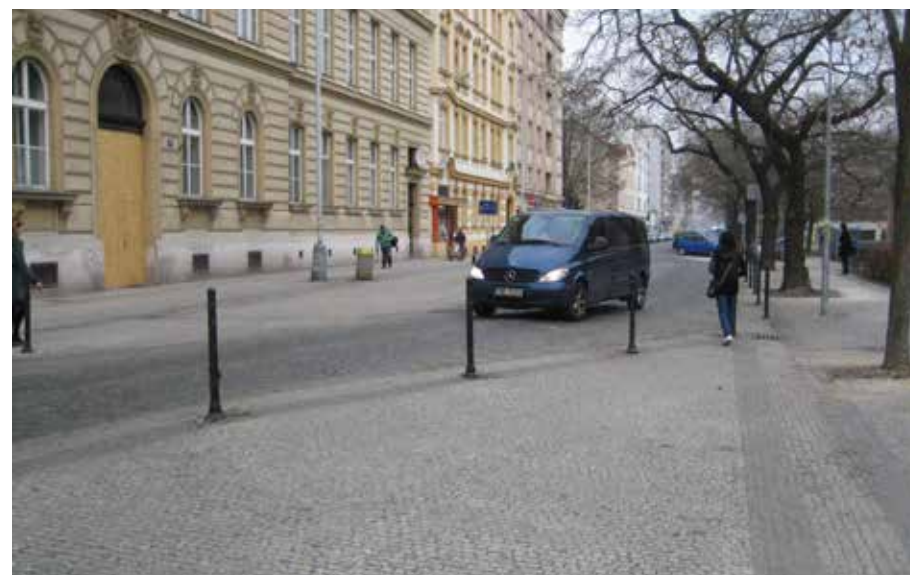
Zpomalující opatření - nepřímé úseky vozovky vymezené zahrazovacími sloupky (Praha).
