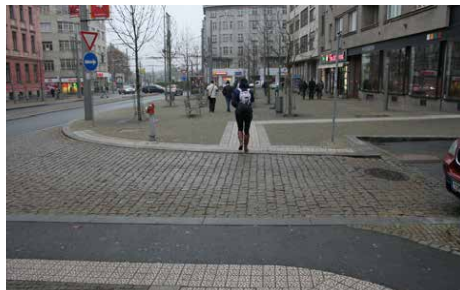
Dlouhý příčný práh (vozovka zvýšená do úrovně chodníku) v místě, kde vedlejší ulice kříží chodník podél ulice hlavní, jako funkční řešení ve prospěch chodců (Plzeň).
