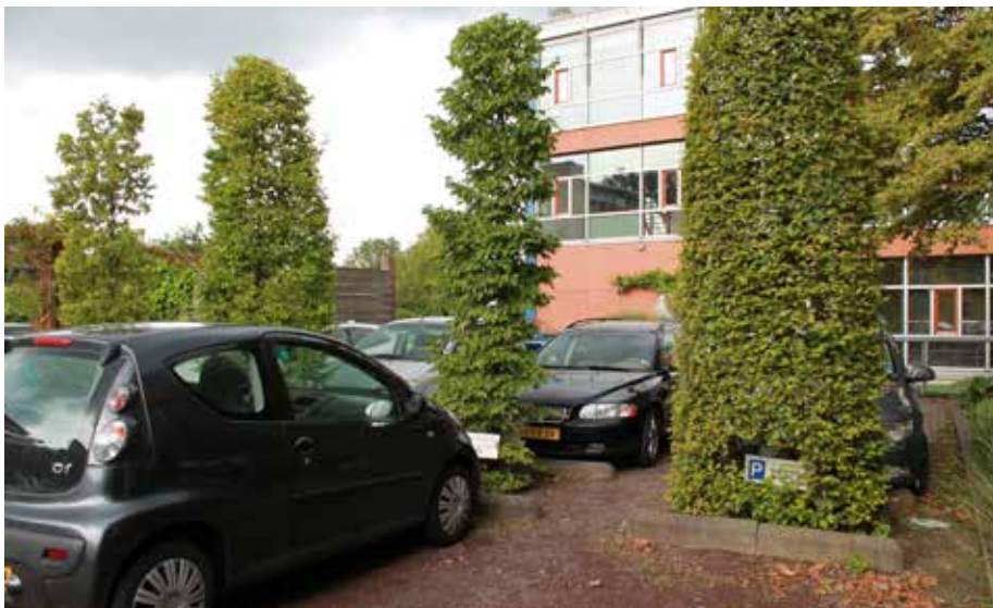
Parkoviště, které odpovídá požadavkům adaptace na změny klimatu je takové, které má vsakovací povrch (štěrk apod.), případně je voda sváděna do průlehu mezi parkovacími místy, zkrátka srážková voda není odváděna pryč (Culemborg, NL).
