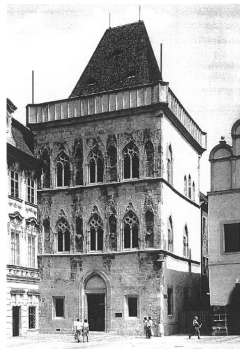
Obrázek č. 13: Praha-Staré Město, dům čp. 605/I U kamenného zvonu po obnově. Foto Vojtěch Obercigner
