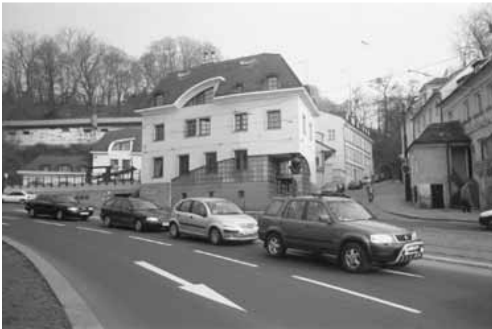
Obrázek č. 21: Hotel Hoffmeister na Klárově, příklad novostavby v MPR Praha. Foto Karel Kibic.
