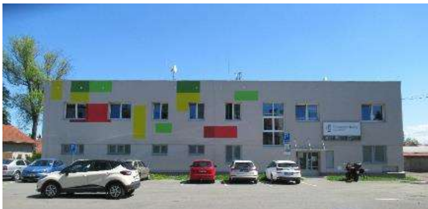
Obrázek 36 Pohled na TS Štramberská 483
