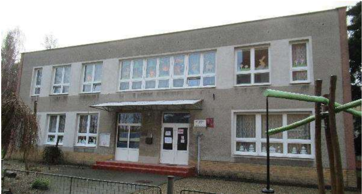
Obrázek 24 Čelní pohled na MŠ Pionýrů 1519
