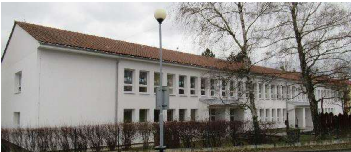
Obrázek 20 Čelní pohled na MŠ Frenštátská 1370
